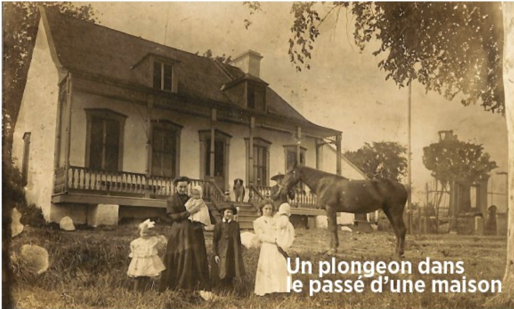
La façade sud de la maison Louis-Philippe Lefebvre en 1910 avec ses lucarnes d'origine et avant l'ajout d'un appentis (Photo : collection Lorraine Bédard)
